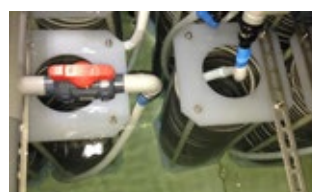
施工例：タンクに組み込んだ投込式熱交換器
