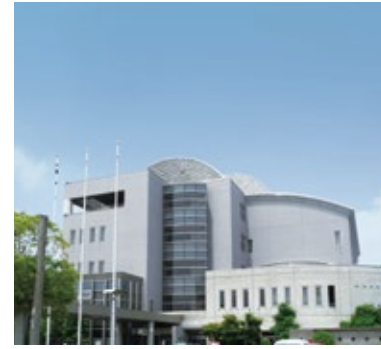
西尾市総合福祉センター 様 (愛知県西尾市)
